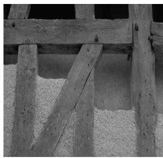
Béton de chanvre en mur
