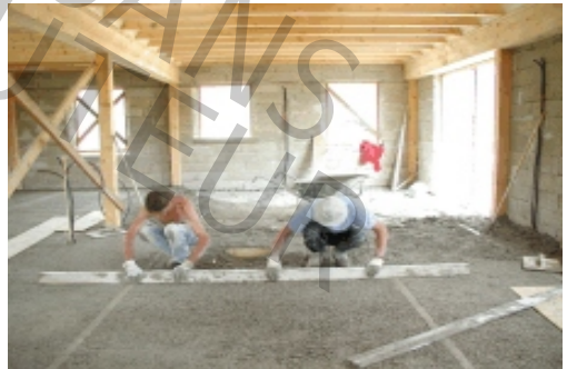
Béton de chanvre en dallage isolant sur terre plein
