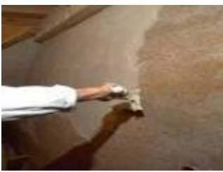
Mortier de chanvre en enduit intérieur
