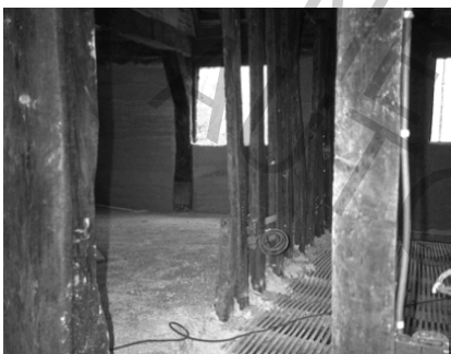
Béton de chanvre isolant sur plancher d'étage
