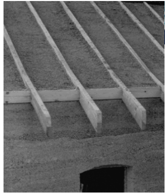
Béton de chanvre en isolation de toiture
