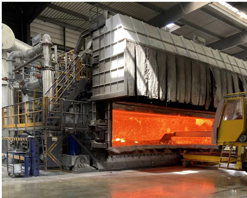
Hydro®, fonderie de Lucé, visite du 30/05/2022
