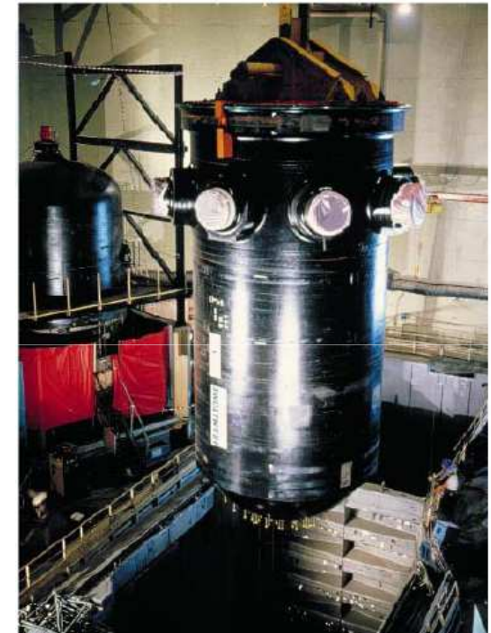
Cuve de réacteur (assemblage de plusieurs viroles par soudage)
